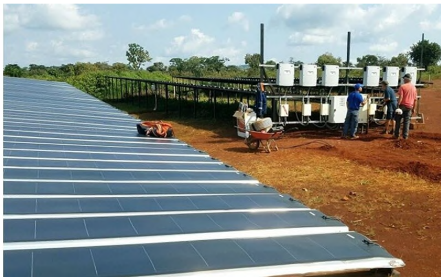
Installation de panneaux solaires au Cameroun. Photo Énergies sans frontières
