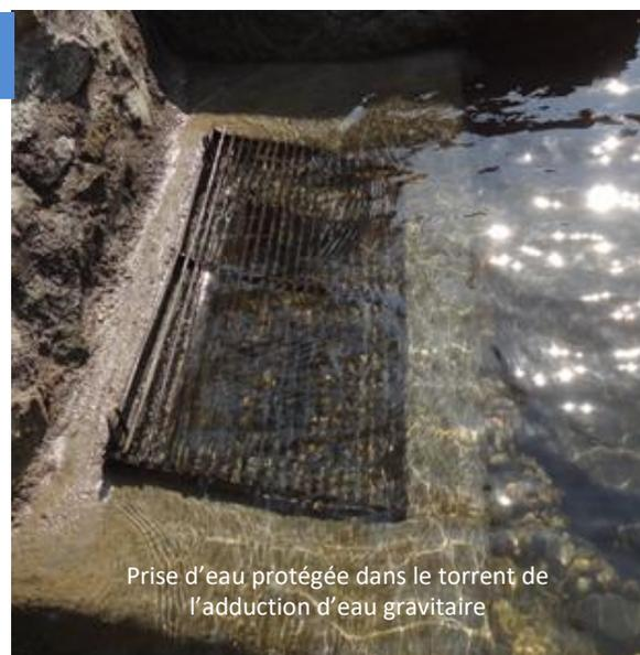
Prise d'eau protégée dans le torrent de l'adduction d'eau gravitaire
